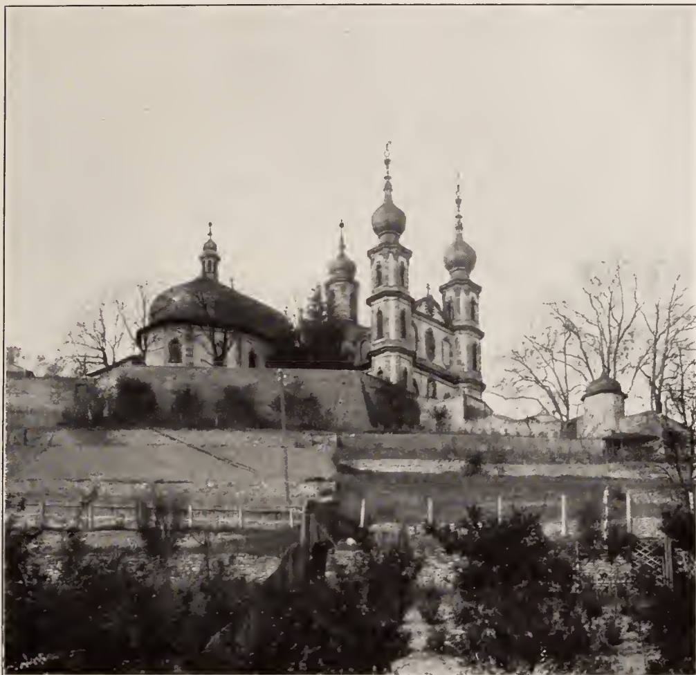
KÄPPELE AUF DEM NIKOLAUSBERG IN WÜRZBURG. ARCHITEKT BALTHASAR NEUMANN. ERWEITERUNG DURCH NEUBAU SENKRECHT ZUR ALTEN KIRCHE. VGL. GRUNDRISS S. 204 — Text S. 206
