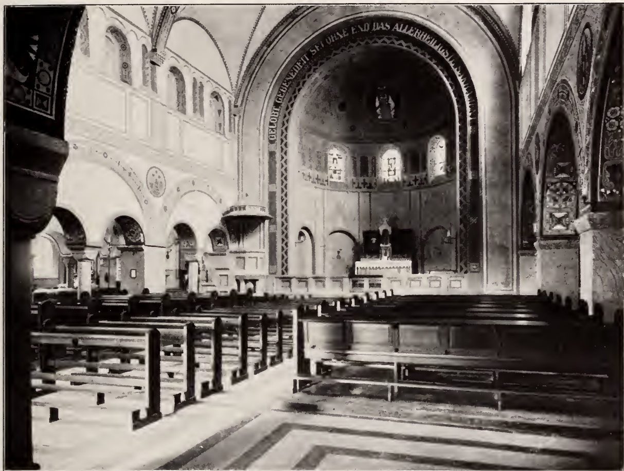
INNERES DER VON EDUARD ENDLER IN KÖLN ERWEITERTEN KIRCHE IN PAFFRATH. Vgl. Grundriß S. 222 und Abb. S. 224
